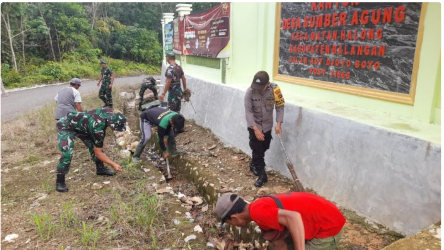
Tanggap Bencana, Koramil 1001-12/Halong Bersihkan Saluran Air
