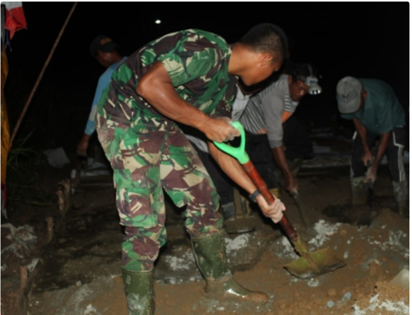
Satgas TMMD 115 Kebut Cor Jalan Hingga Malam Hari
