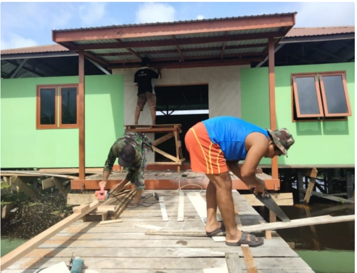
Satgas TMMD Ke-115 Kodim 1001/HSU/BLG Finishing Balai BPD Kampung Trans Lanjar
