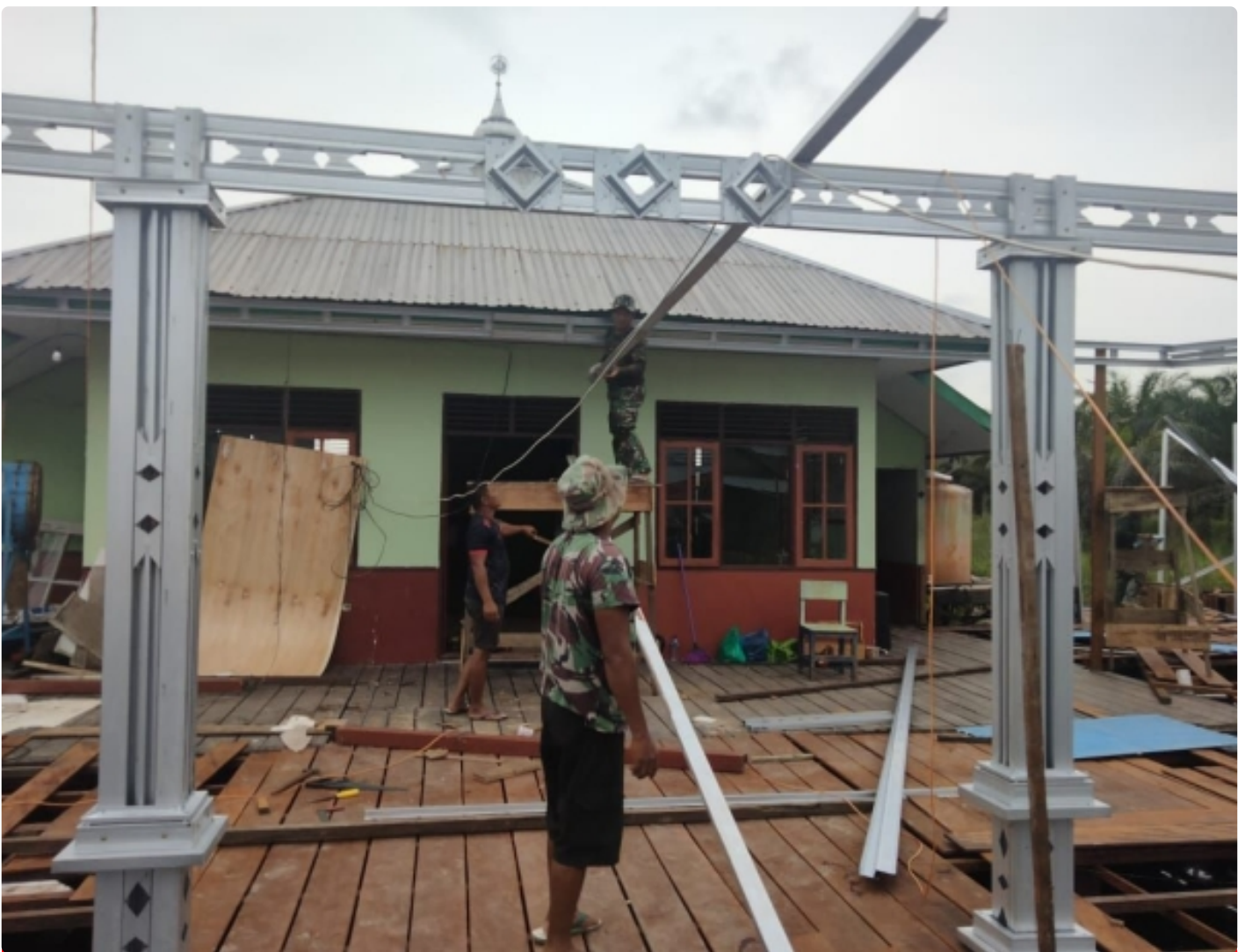
Pengerjaan Lantai dan Atap Tempat Ibadah Sebagai Sasaran Fisik TMMMD
