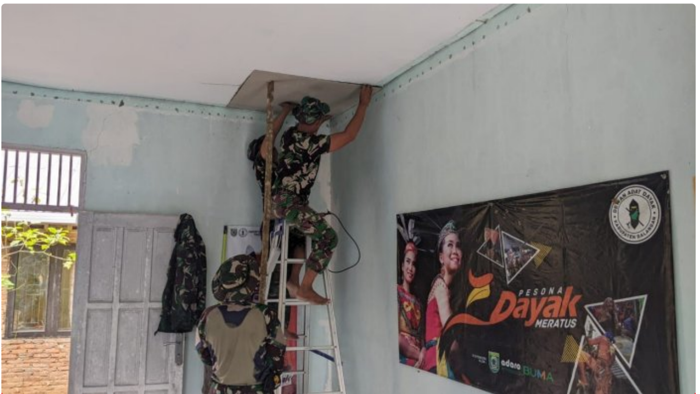
Kodim 1001/HSU-Balangan Rehap Kantor DAD Kabupaten Balangan
