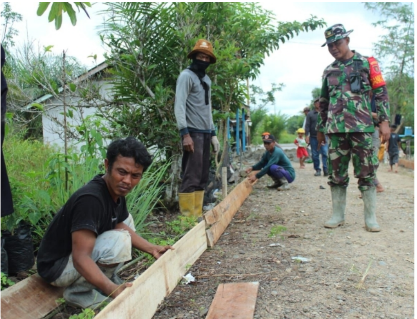
Kembali Persiapkan Pengecoran Satgas TMMMD 115 Pasang Papan Bekisting
