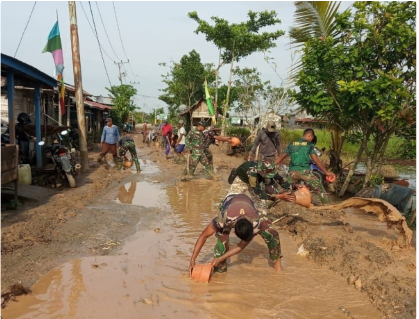
Personel Satgas TMMD Kuras Kubangan Lumpur Demi Perlanjar Pengecoran Jalan
