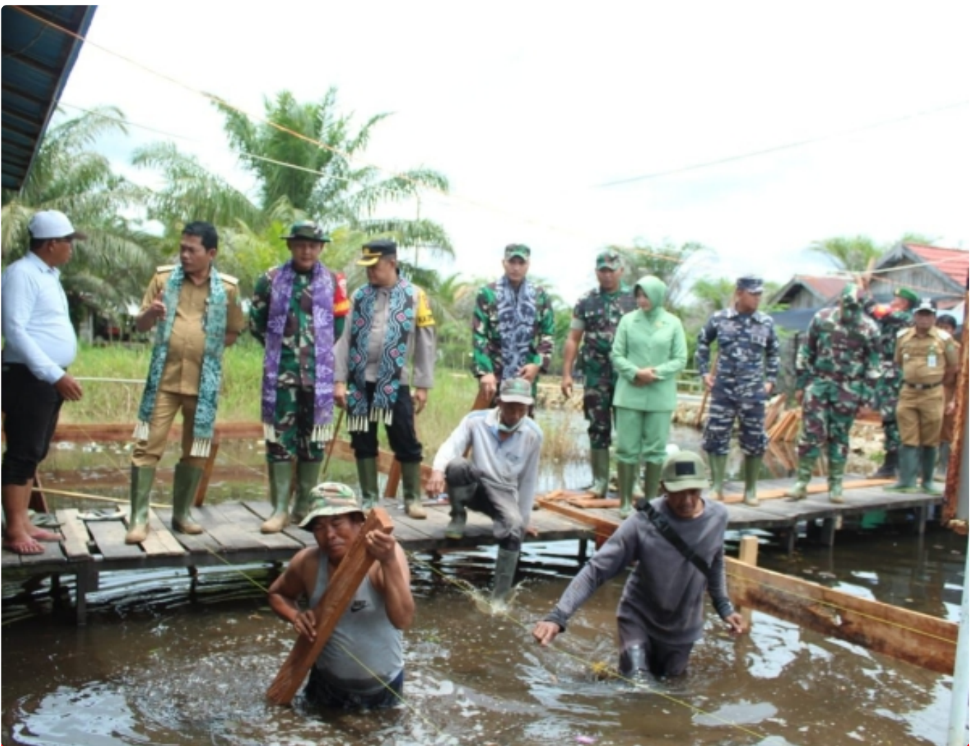
Forkopimda Balangan Tinjau Lokasi TMMD Ke -115 Kodim HSU-Balangan
