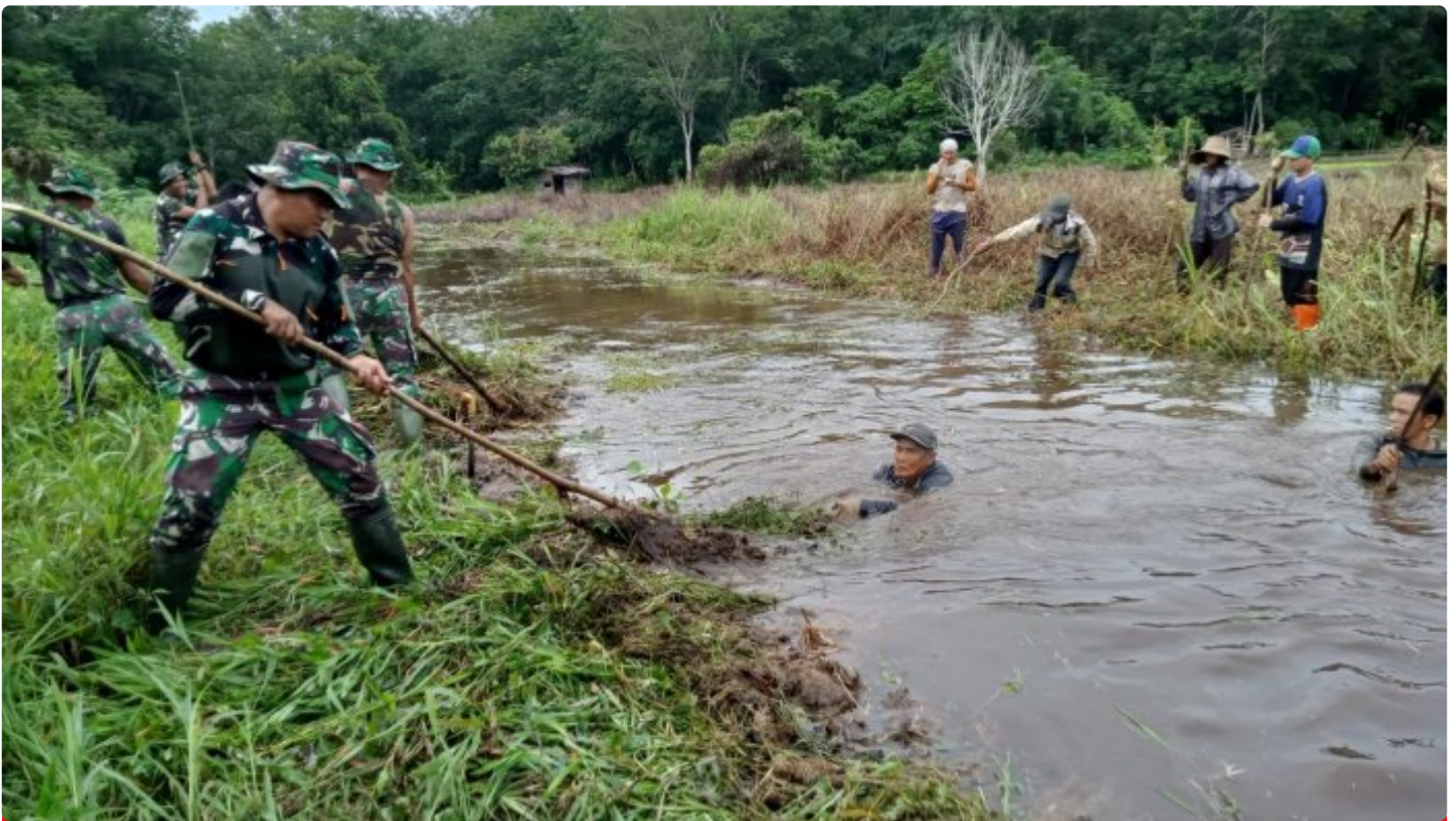
Cegah Batingsor Koramil 1001-05/Lampihong Bersihkan Saluran Air
